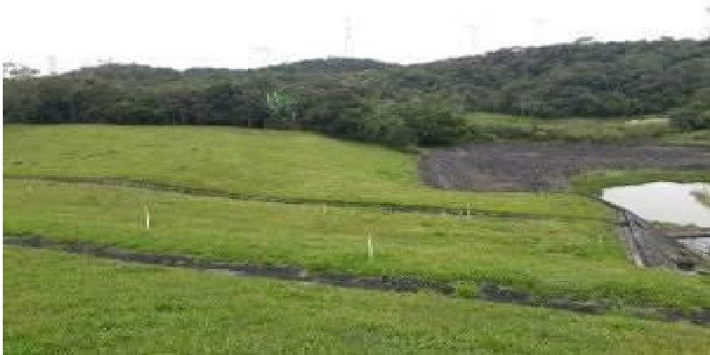
Dique do Rio Pequeno- Sangradouro Pequeno Perequê: Maciço de terra esquerdo
