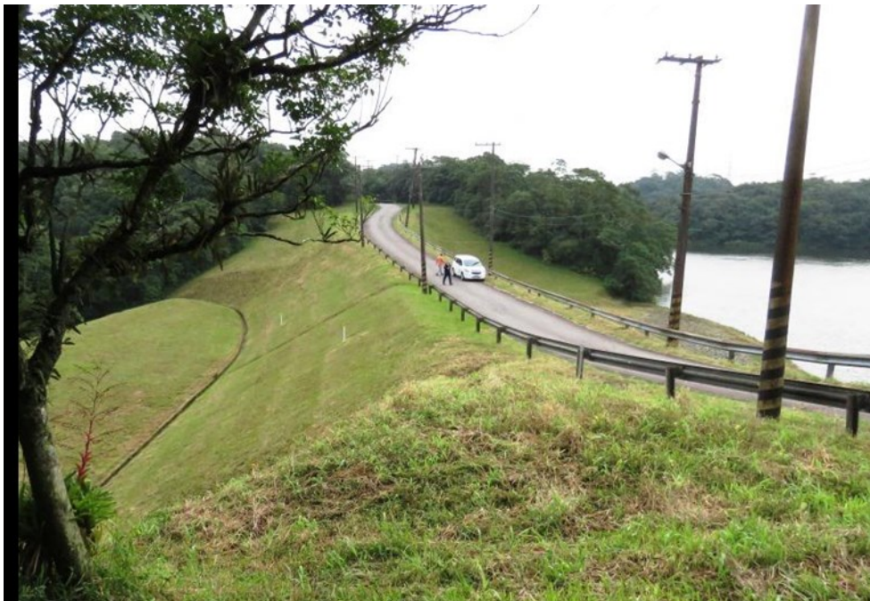
Ilustração 10 – Dique do Córrego da Cascata
