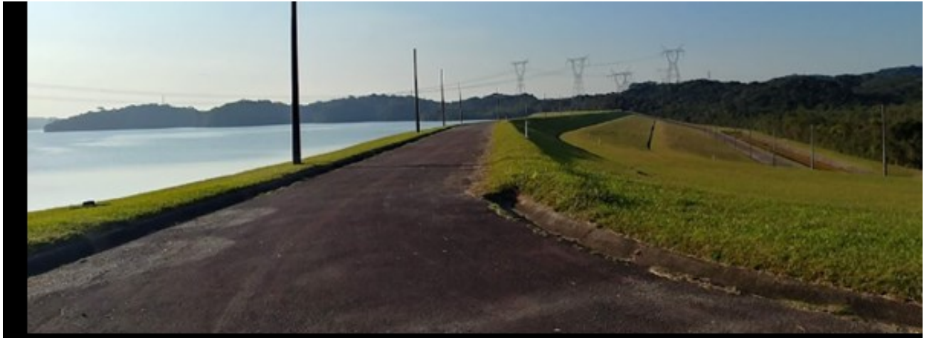
Ilustração 6 – Dique do Marcolino (Foto Victor Benincasa)
