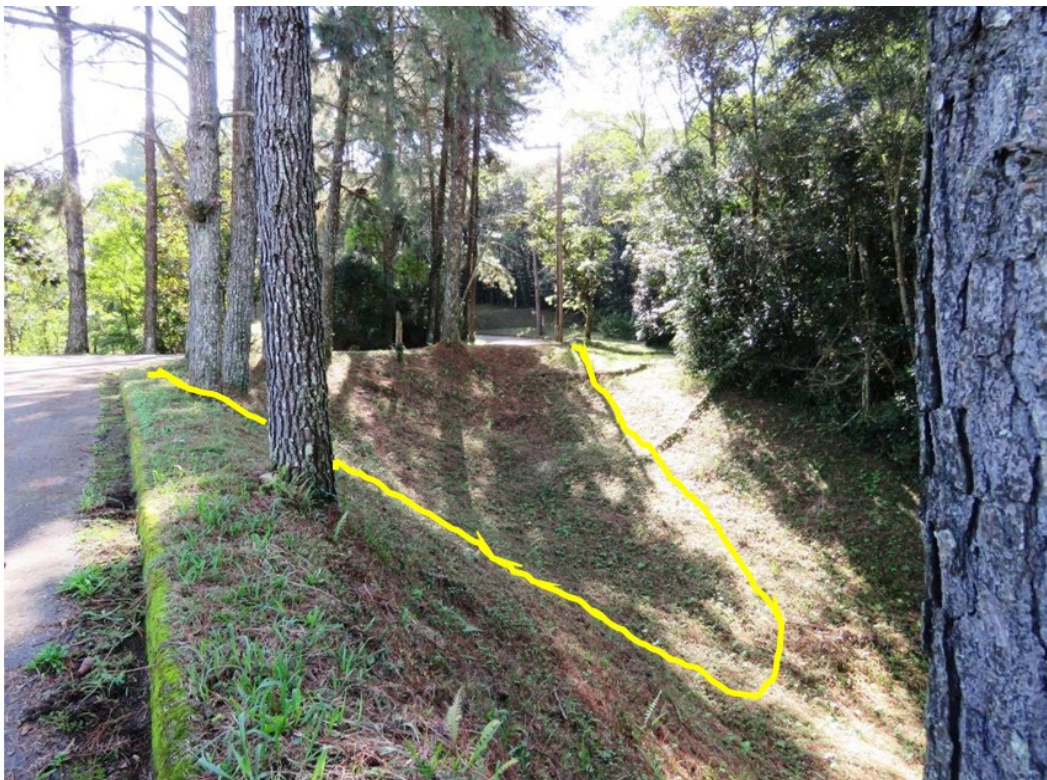
Ilustração 4 – Vista do talude de jusante do Dique Sete
